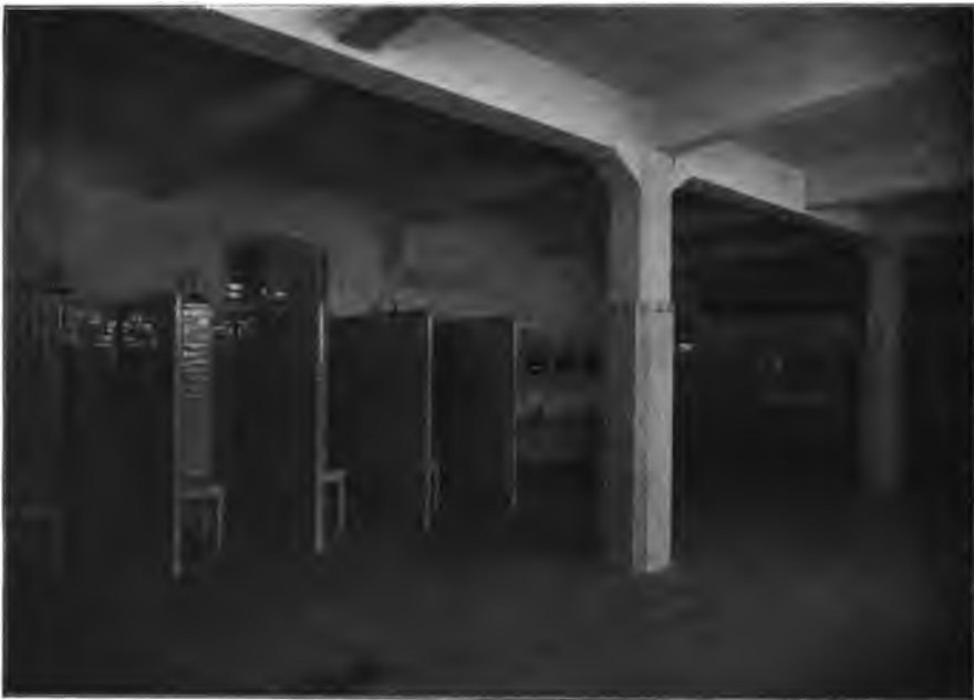
Abb. 53. Waschraum in der Turnhalle des Männerturnvereins München. Arch. Gebr. Rank.
